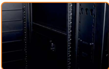
Положение передних и задних направляющих может быть отрегулировано по глубине с фиксированным шагом 6,4 мм.
